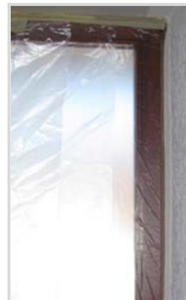
5. Heizkörper können durch Folie, die hinter den Heizkörpern angebracht wird, geschützt werden. Eine Folie kann auch zum Schutz des aufgerollten Fensterladengurts dienen. Eine andere Möglichkeit ist, eine Tüte um den Fensterladen zu wickeln.
