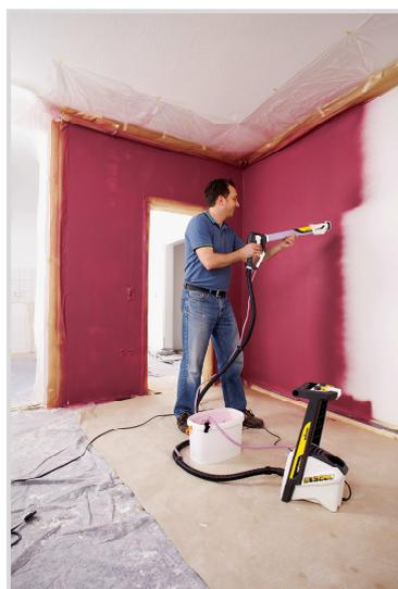
1. Retire todos los objetos de la habitación y cubra el suelo; como alternativa, cubra los muebles. Utilice para este fin cartón, velo de fibras y/o láminas protectoras. Además, cubra las puertas y las esquinas con cinta adhesiva. Preste atención a que la cinta adhesiva quede perfectamente adherida.
