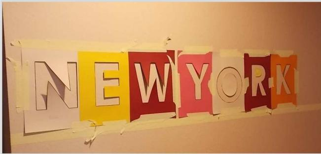
4. El puesto de trabajo se debería cubrir con cartón. Diluya la pintura hasta un 10% (observe las indicaciones del fabricante de la pintura). Antes de proyectar la pintura se debería realizar una prueba de pulverización.
