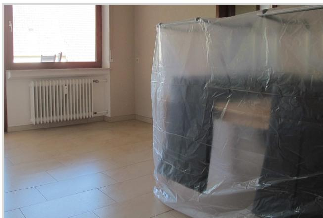
2. Des cartons ou une étoffe de protection peuvent servir à recouvrir le sol, mais il faut les fixer soigneusement avec du ruban adhésif. Les prises électriques peuvent être masquées. ATTENTION au courant électrique : il faut le couper le cas échéant. Masquer également les plinthes.
